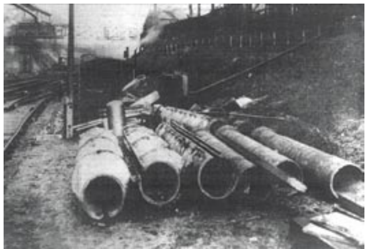
Niewiele pozostało po tych kilku latach świetności kolei atmosferycznej. Elementy tuby trakcyjnej na stacji West Croydon wykopane zostały w 1933 r.
